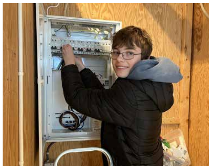
ØVER: Didrik Holmberg Bendixen på VG1 over på montering av sikringsskap.
