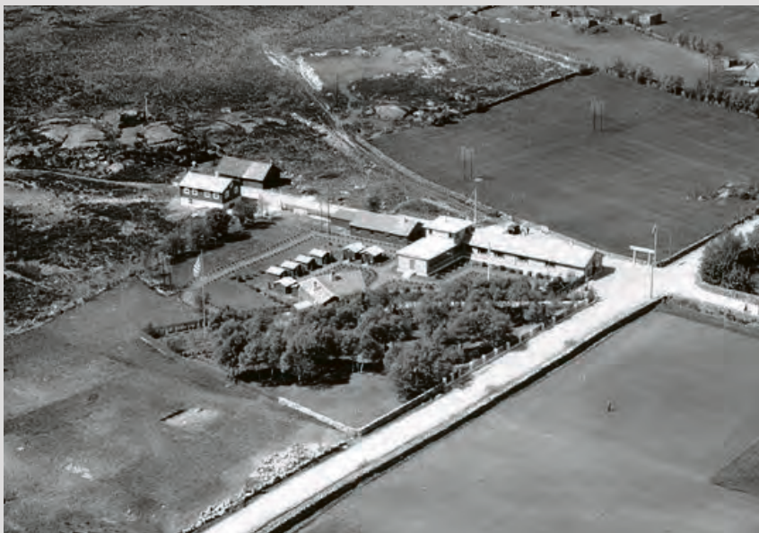
FØR: Bilde tatt ca. 1936. Ved sportskafeen var det følgende bygninger. En restaurant, småhytter i parken og en lagerbygning i forlengelse av hovedbygningen. (Foto Stavanger Byarkiv)
