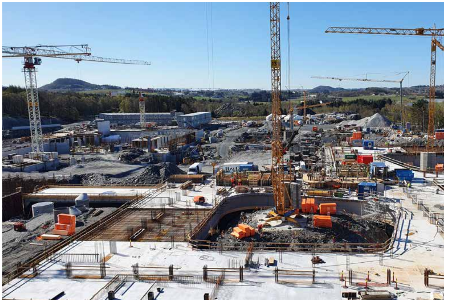
Her er dekket ferdig støpt før de syv heissjaktene skal støpes.
